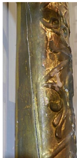
Fotografía 17. Detalle de fisuras en la columna izquierda.
