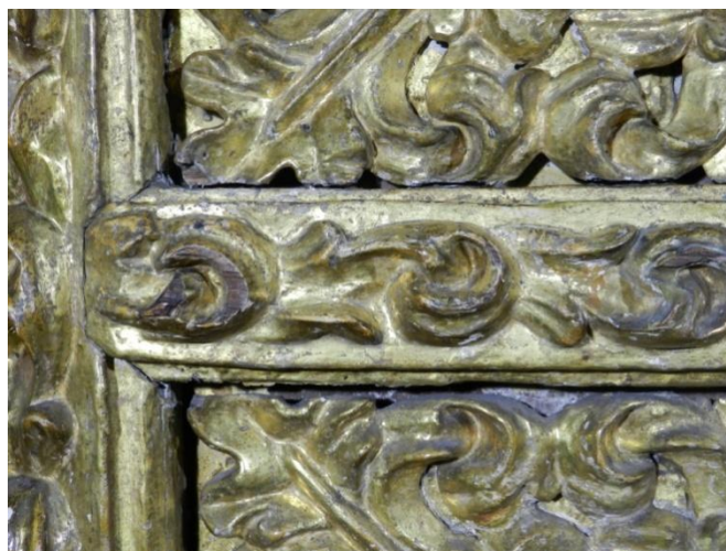
Fotografía 19. Faltantes en las tallas salientes de las molduras que separan los tableros en la columna.
