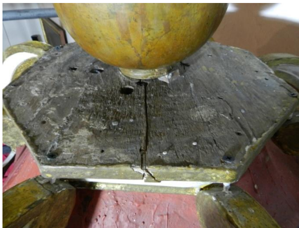
Fotografía 12. Detalle de la base de la esfera base del ángel. Donde se aprecia una fisura profunda.
