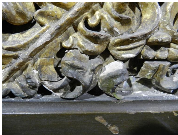
Fotografía 18. Faltantes de talla en los tableros inferiores de la columnas.
