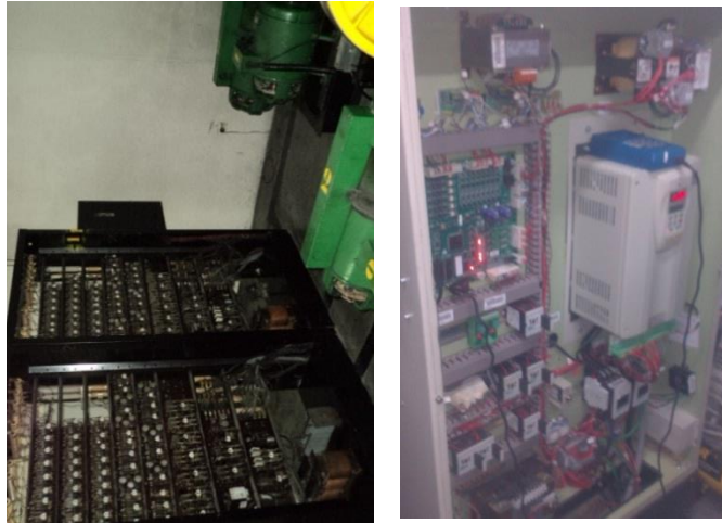
Modernización de ascensores
