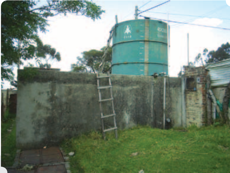
Figura 14. Tanque de agua del barrio Serrezuela
